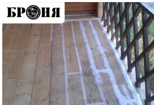
Гидроизоляция и последующая теплоизоляция.
