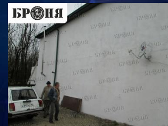
Броня Лайт и Броня Акваблок, тепло и гидроизоляция цоколя частного дома
