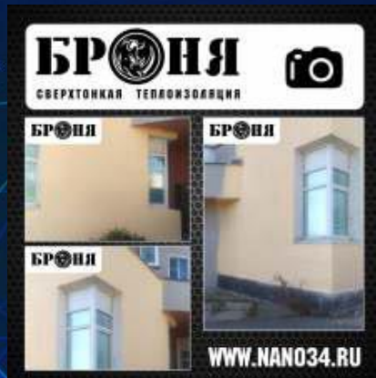
Теплоизоляция Броня Норд при теплоизоляции фасада здания г. Череповец
