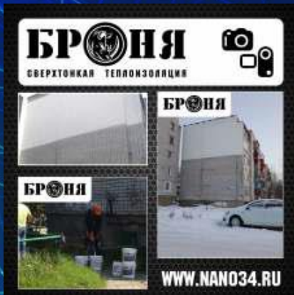
Теплоизоляция Броня Фасад при утеплении стен торцевых квартир в многоквартирном жилом доме г. Сургут
