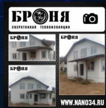
Теплоизоляция Броня Фасад при утеплении частного домовладения в г. Череповец
