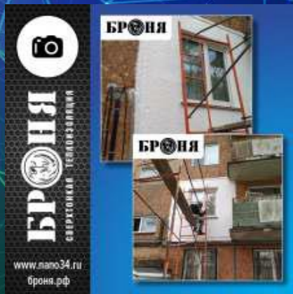
Утепление стены квартиры с внешней стороны Теплоизоляцией Броня Стена в г. Владивосток
