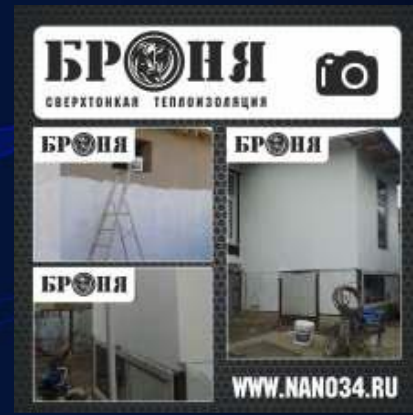
Утепление фасада частного дома Теплоизоляцией Броня (г. Алматы)
