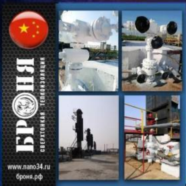
Начало работ по теплоизоляции реакторного оборудования и паропроводов на нефтехимическом предприятии в КНР
