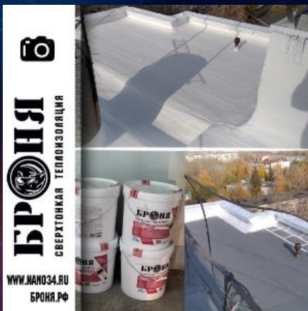
Броня Акваблок в капремonte на кровле дома, г. Ульяновск
