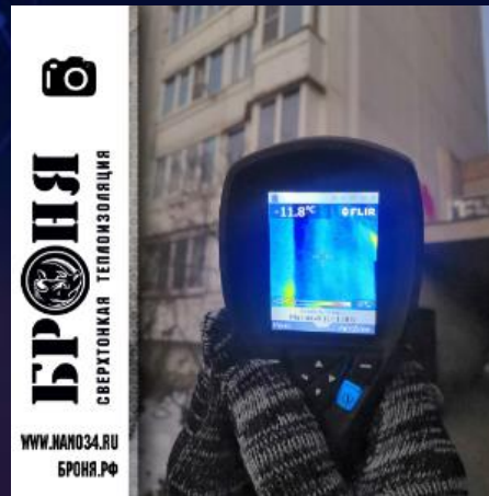
Тепловизионные замеры Броня Фасад и подтверждение эффективности в капремonte на основании разницы температуры «до и после». г. Кострома
