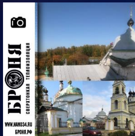
Броня Металл и Броня Акваблок на кровле Церкви Введение во храм Пресвятой Богородицы. г. Плёт, Ивановская обл
